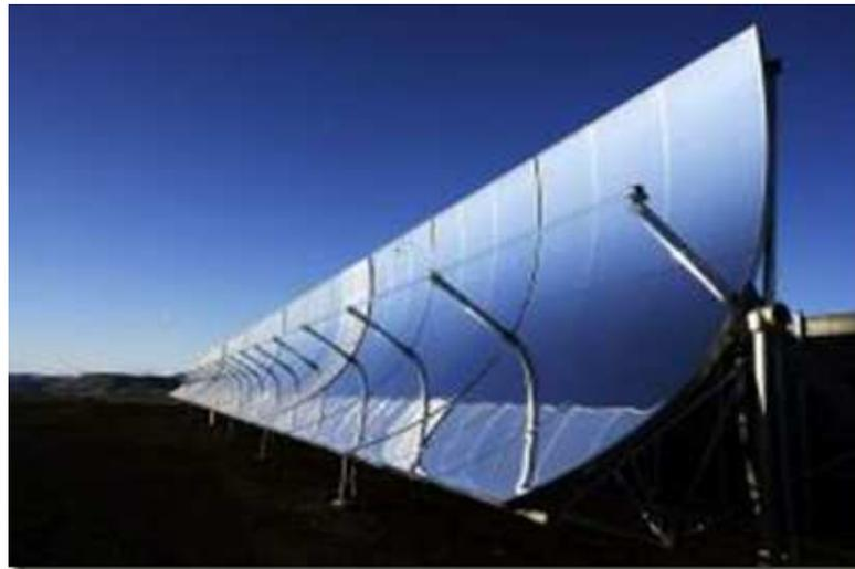
Fig. 3.1: Concentrador cilindro parabólico.
